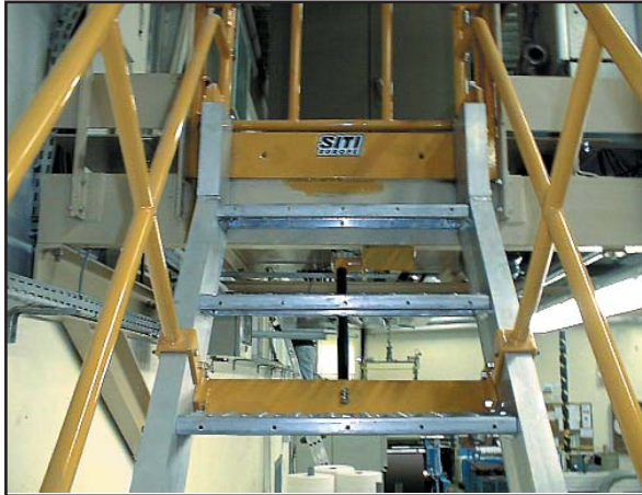
Couloir d'accès en montée
