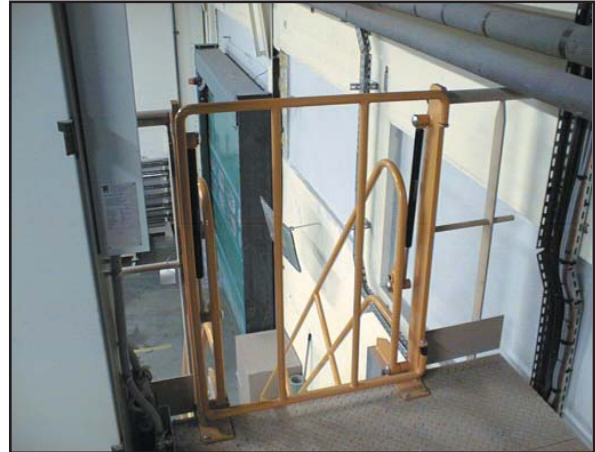
Protection permanente sur le plancher
