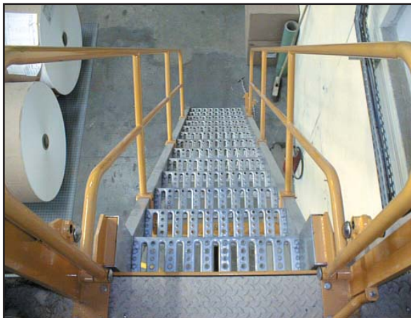
Escaliers face à l'utilisateur en descente
